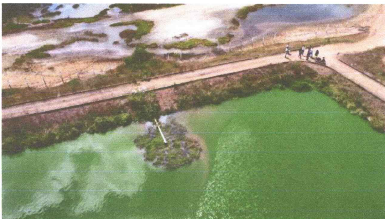
Imagem 4 – Vista aérea de uma das lagoas de tratamento. Observar o assoreamento no ponto de entrada da lagoa.
