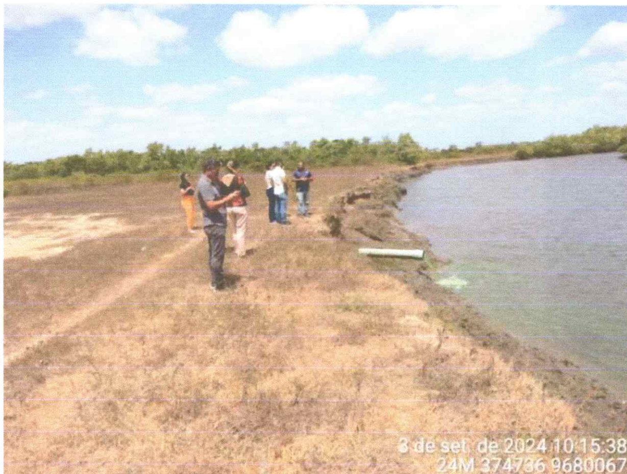
Imagem 3 – Ponto de lançamento de efluentes no Rio Acaraú. Observar a coloração do efluente.
