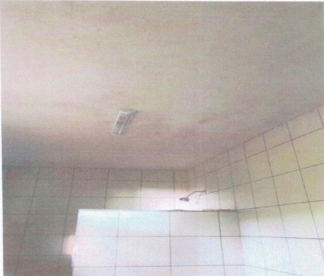
Foto 04 – Vista do banheiro com infiltração da cobertura, que se apresenta em vários outros pontos da UBS Aranaú
