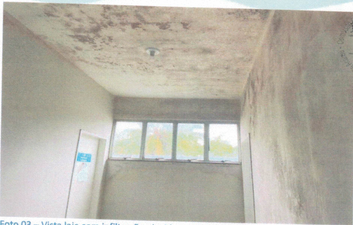
Foto 03 – Vista laje com infiltração, devido a não funcionalidade da cobertura.
