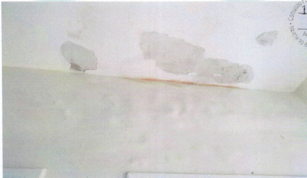
Foto 03 – Vista do revestimento da laje com deslocamento provocado pela infiltração.
