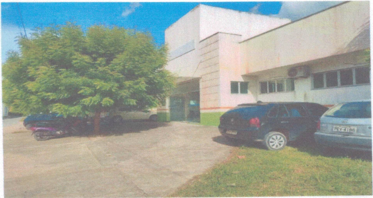
Foto 06 – Vista do acesso frontal necessitando adequação de estacionamento e acesso.
