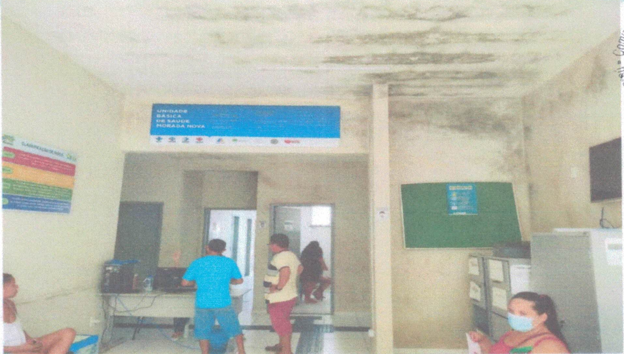
Foto 05 – Problemas de infiltração da cobertura, que apresenta deteriorada e sem funcionalidade.
