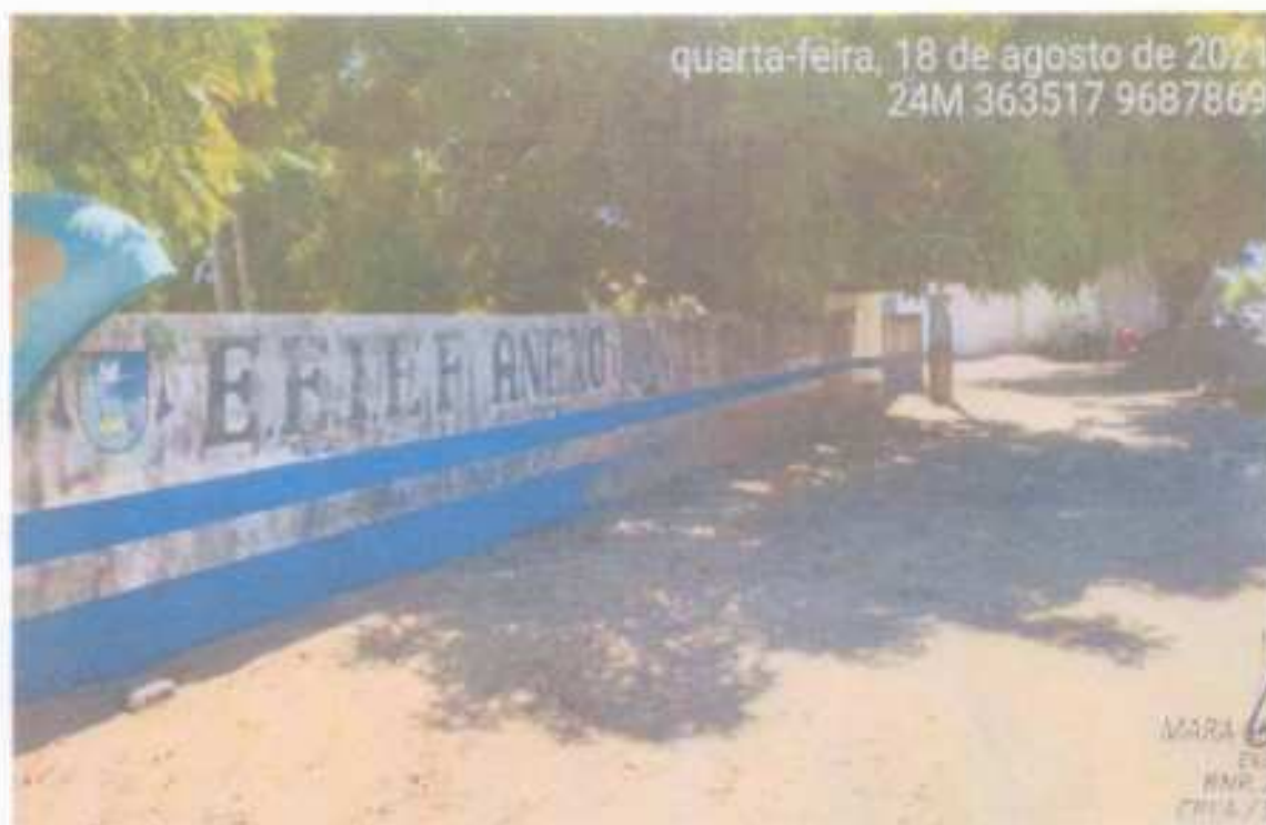
Foto 06 - Vista da fachada frontal que apresenta falta de calçada, acessibilidade e altura de muro abaixo da altura prevista em norma.
