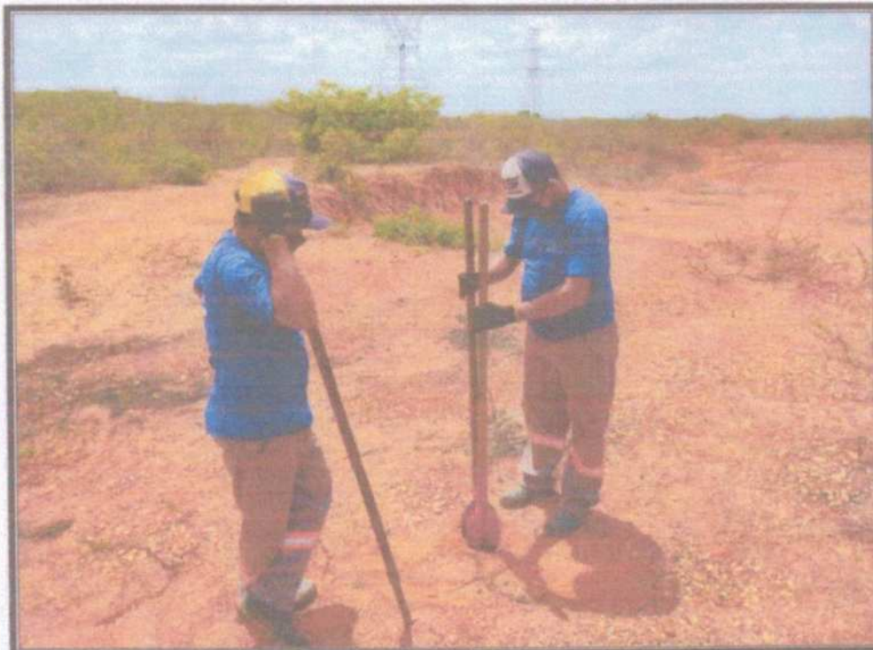
FOTO 2 – EQUIPE PREPARANDO MAIS UMA SONDAGEM (SPT) NA JAZIDA DE EMPRÉSTIMO DA UNIVRSIDADE ESTADUAL VALE DO ACARAÚ-UVA
