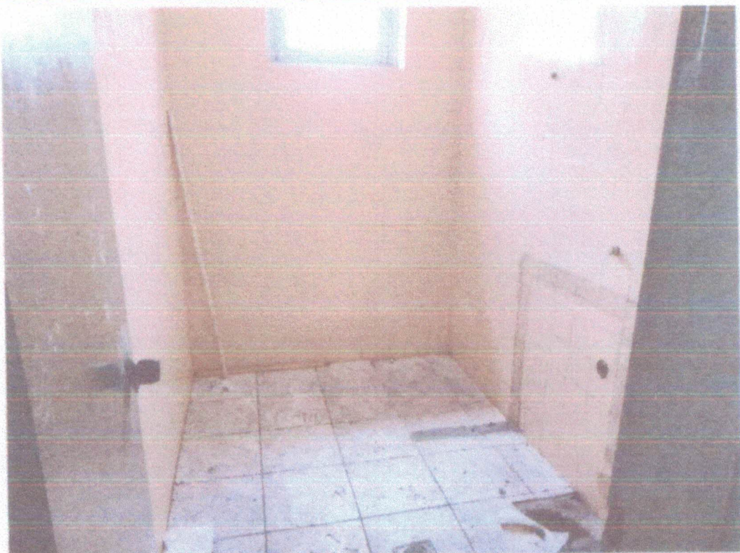
Figura 11 – Banheiro desativado (futuro depósito)
