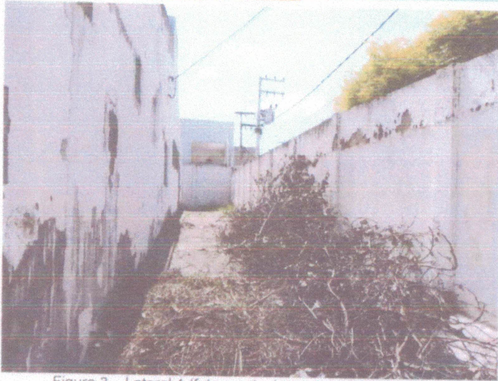
Figura 3 – Lateral 1 (futuro estacionamento para viaturas).
