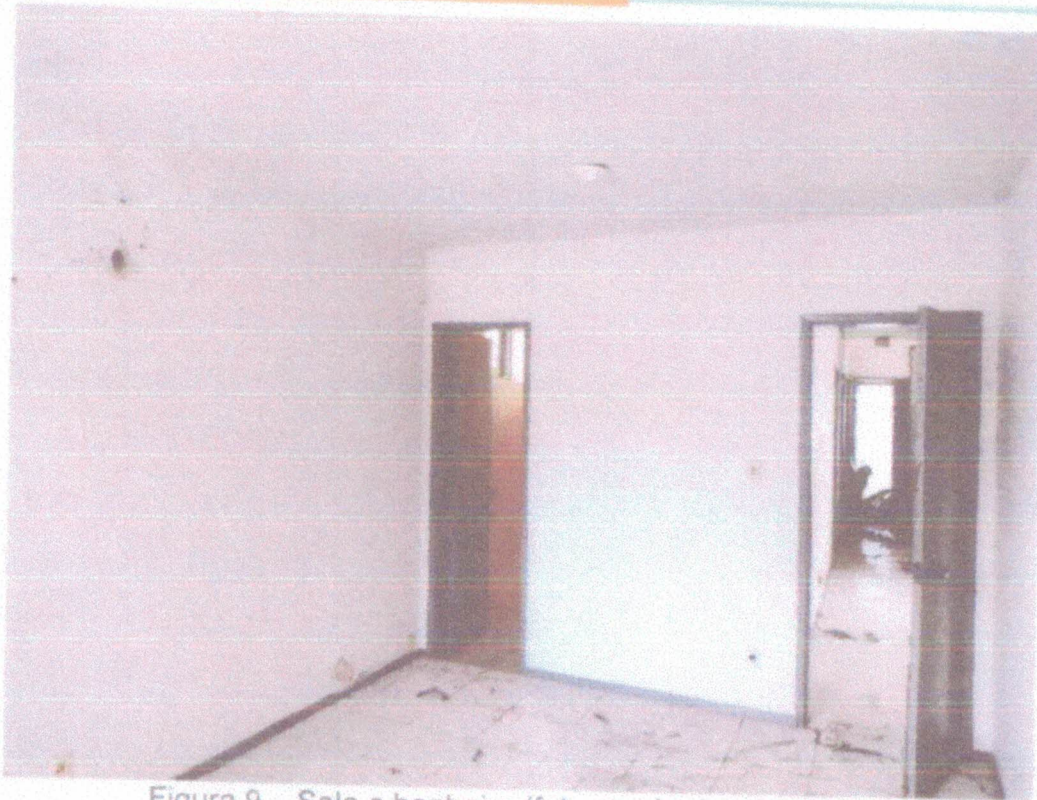
Figura 9 – Sala e banheiro (futura sala do secretário).
