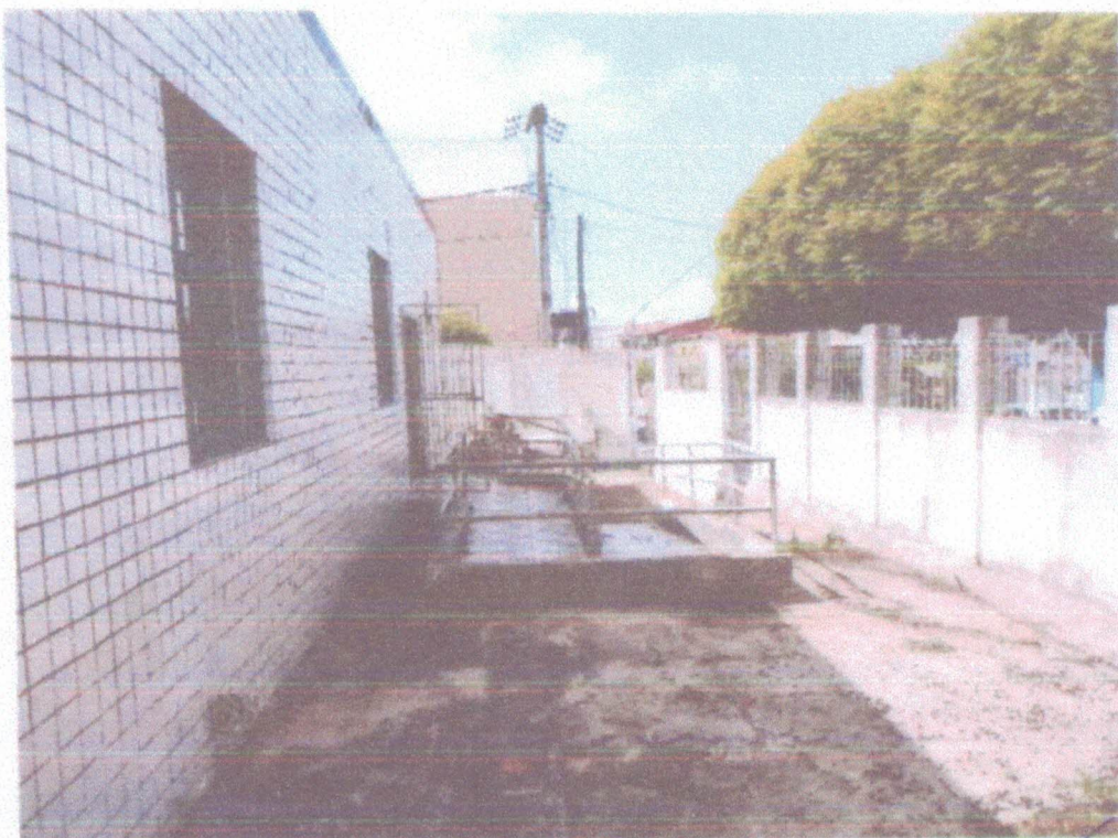
Figura 2 – Espaço entre o muro e a fachada
