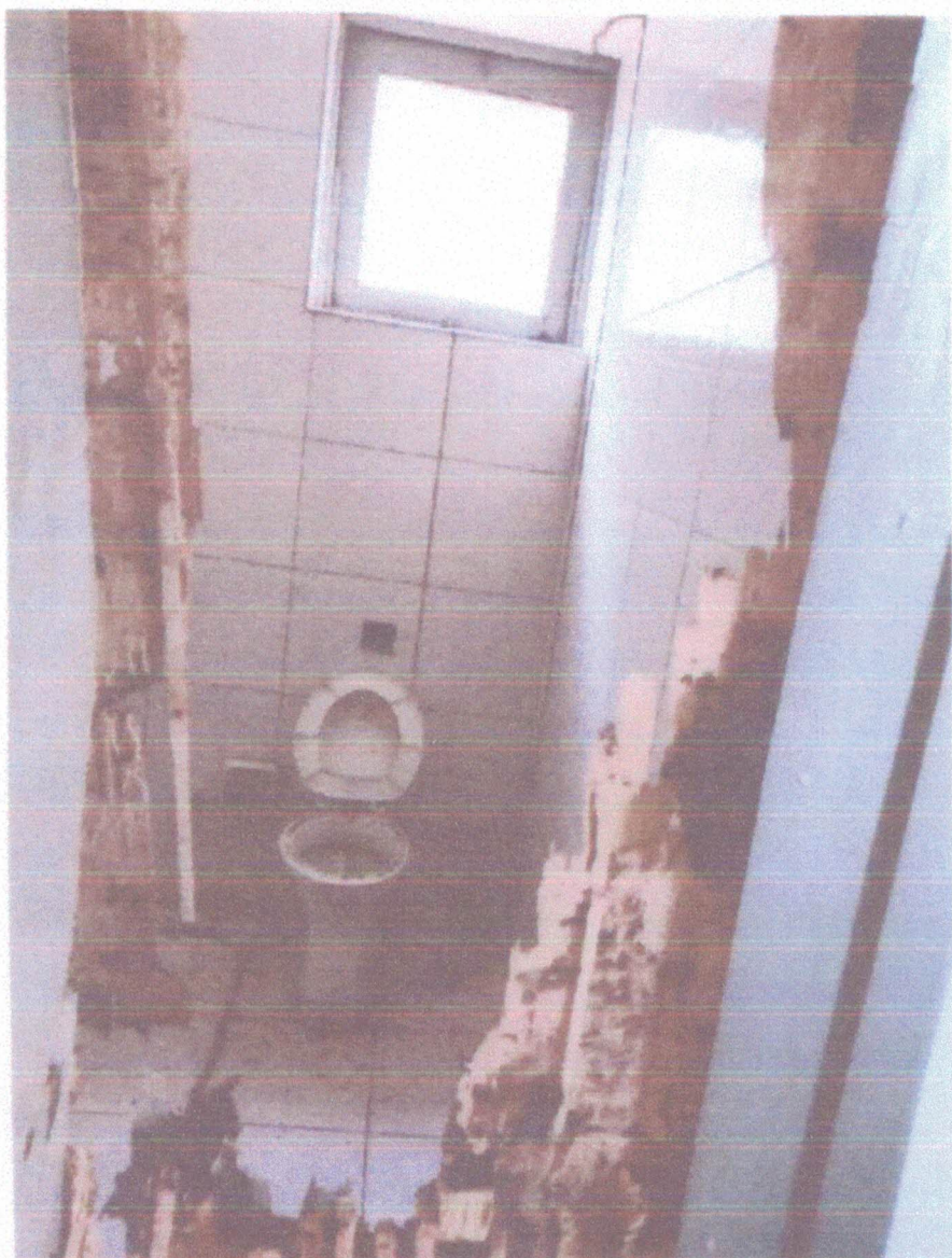
Figura 13 – Banheiro (atendimento aos servidores).
