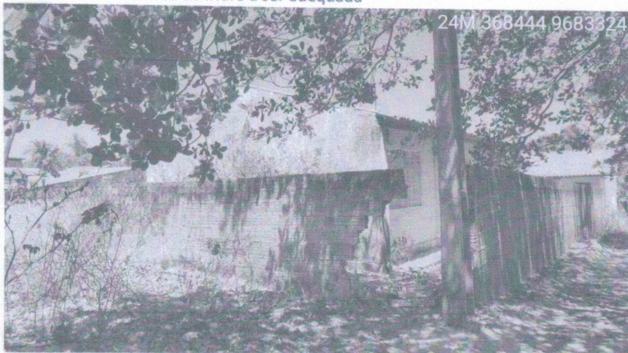
Foto 02 – Vista da área do muro a ser adequada
