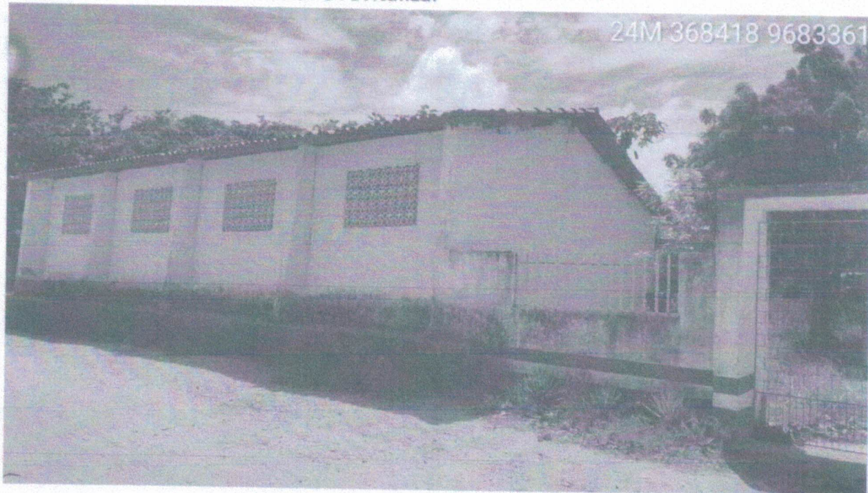
Foto 01 – Fachada a reformar e revitalizar
